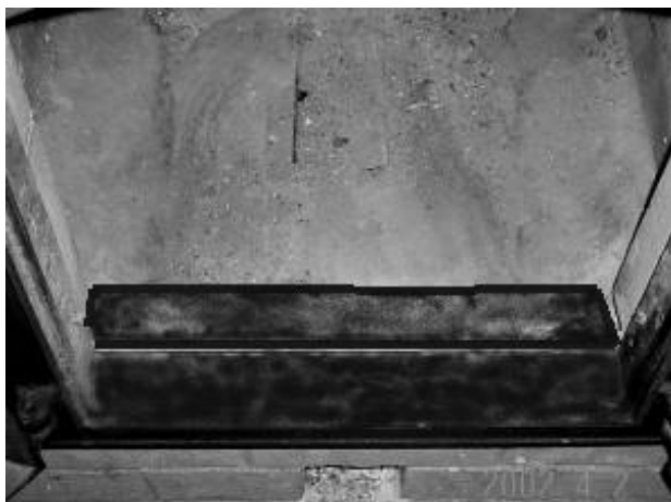
Schéma 8 La barre d'air est installée avec du mortier aux deux bouts. Voir le Schéma 7 pour les dimensions.
